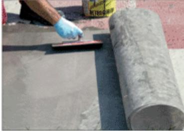
BETONGUAINA® è un rivestimento impermeabilizzante per tetti piani, terrazze e balconi ad elevata traspirabilità che, dopo applicazione, permette al vapor d'acqua contenuto nel supporto di uscire attraverso il manto impermeabilizzante ( $\mu$  1.500 ,
