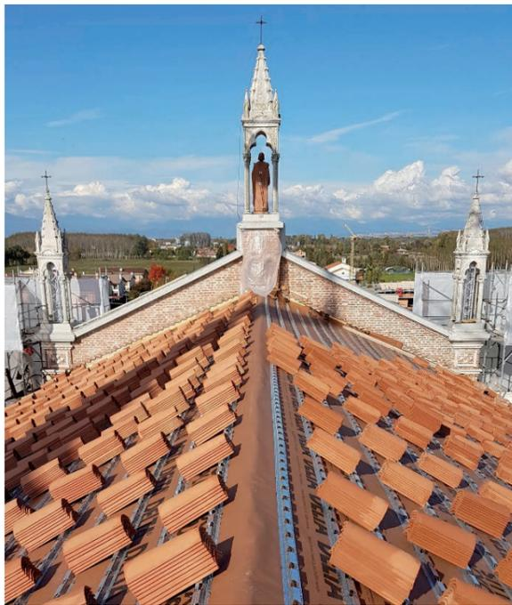
Il sistema Jolly prevede l'aggancio puntuale dei coppi di coperta, garantendo un'ottima resistenza allo scorrimento degli stessi e nel contempo la ventilazione sottomanto. Il sistema Jolly è composto da: elemento anti volatile in metallo forato, listello in acciaio alluminato forato, coppi di Industrie Cotto Possagno, colmo ventilato per coppi "INOX WIND".
