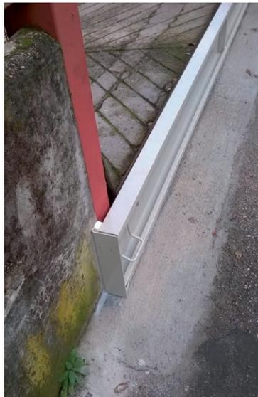
avvallamenti che compromettano la tenuta stagna. Inoltre è stato annegato nel getto del cordolo un tubo quadro in acciaio zincato 80x80 spessore 8 mm, posato perfettamente in bolla con la funzione di soglia di battuta per la paratia, mentre le guide sono state applicate all'esterno del muretto di recinzione.
