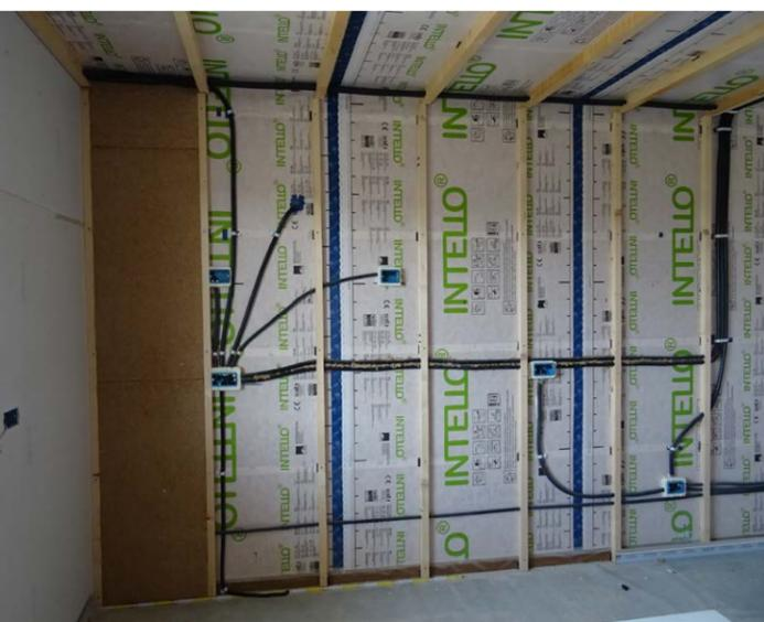
l'approfondimento delle caratteristiche dei prodotti in commercio e una particolare cura nella posa, ha permesso di ottenere l'impressionante risultato di 0,28 h-1 nel BLOW DOOR TEST utilizzando prodotti naturali di NATURALIA BAU.
