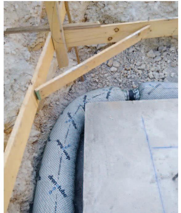
dissipazione delle acque in **un solo passaggio**, unicamente posando il tubo già dotato di tutti gli elementi necessari per la filtrazione (particelle in eps che sostituiscono la ghiaia e filtri geotessili). I moduli di Drenotube®, di 3 o 6 metri di lunghezza, sono estremamente **facili e veloci da posare, anche senza manodopera specializzata**.
