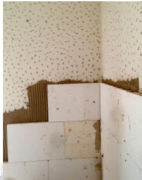
mm in modo di ridurre la quantità di spazio per la coibentazione sottratta all'ambiente interno, privilegiando il confort igrometrico.
