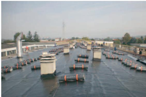
una guaina con flessibilità al freddo -20°, è costituito da **Index Firestop poliestere, resistente al fuoco**, additivata con ritardanti di fiamma innocui e autoprotetta con scagliette di ardesia.
