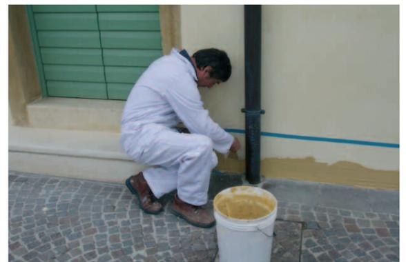
alla **finitura colorata**: per la facciata della villa l'obiettivo era di mantenere l'effetto non uniforme caratteristico dei colori alla calce. Per questo motivo è stato scelto BIOCALCE FONDO, fondo intermedio riempitivo minerale specifico per fondi disomogenei o micro cavillati prima dell'applicazione di cicli decorativi traspiranti alla calce. Successivamente, come finitura si è scelto BIOCALCE MARMORINO, uno stucco naturale idoneo
