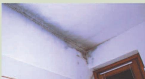
Pulire per bene il muro con acqua calda e detersivo. Di seguito spruzzare un prodotto antimuffa naturale sul muro contagiato.
