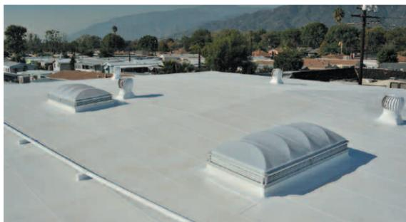
Le coperture esistenti difficilmente sono state realizzate pensando a limitare il riscaldamento da irradiazione solare che specialmente nel caso di superfici scure, come ad esempio le membrane bitume polimero, può portare la temperatura del supporto a valori superiori gli 80 °C.
