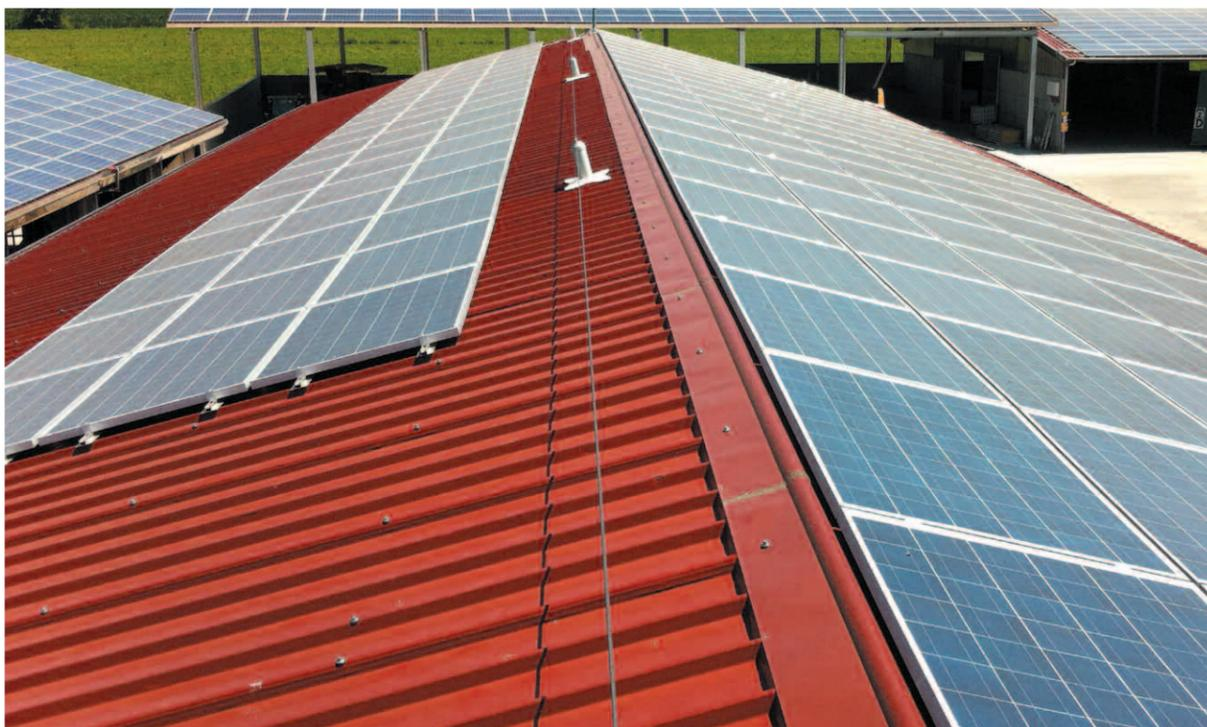
Per entrambe i siti industriali si è optato per l'utilizzo del sistema **EVOLUTION LEAP** che consente la sua installazione direttamente sul pannello sandwich: ciò evita di effettuare tagli sul pacchetto di copertura e di causare l'insorgere di problematiche legate all'impermeabilizzazione o a ponti termici.
