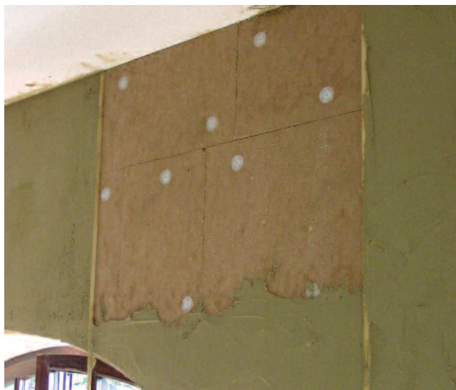
Fase 4 - Stesura dell'intonaco Naturaclay-Special.
