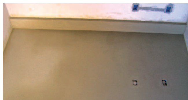
Fase 4 - Rivestimento per eliminare i ponti termici.
