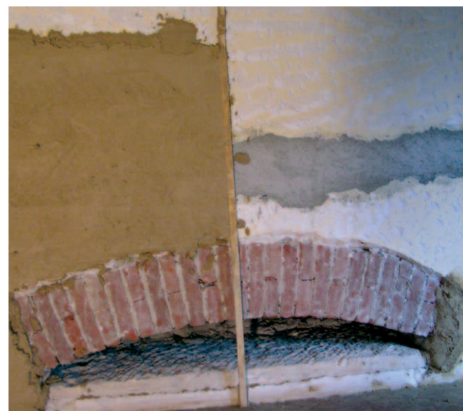
Fase 2 - Stesura della malta Naturaclay-Assorb.
