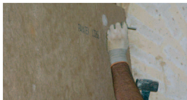
Fase 3 - Fissaggio dei pannelli con tasselli.
