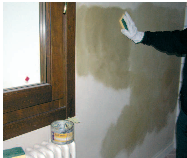
Fase 5 - Stesura della cera idrorepellente.
