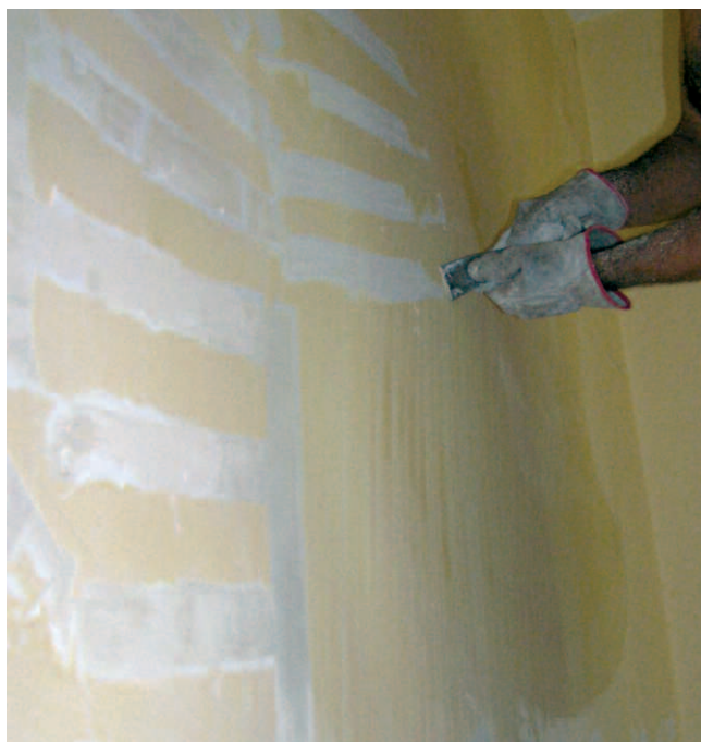
Fase 1 - Asportazione della pittura dal muro.
