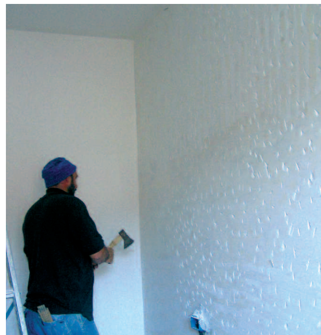
Fase 1 - Picchiettatura del muro.
