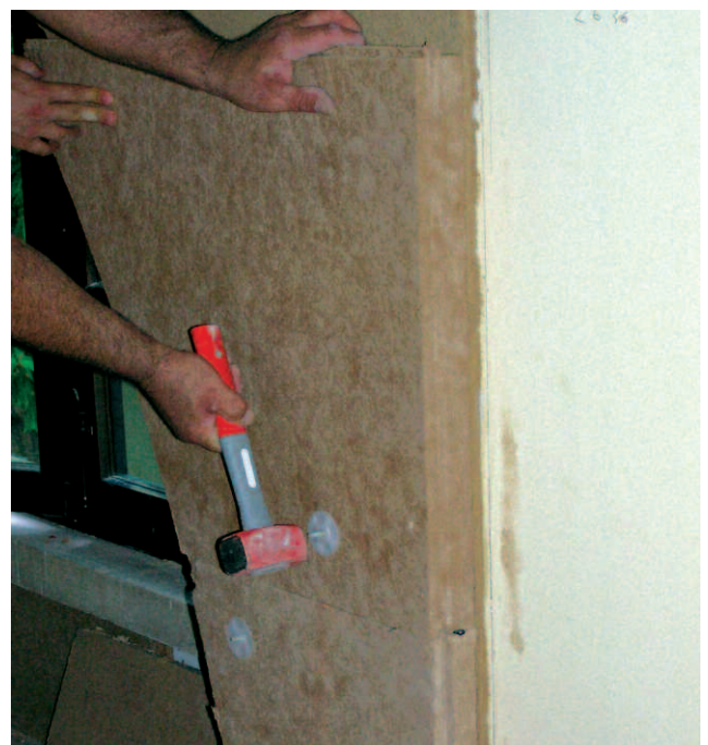
Fase 3 - Fissaggio dei pannelli con tasselli.
