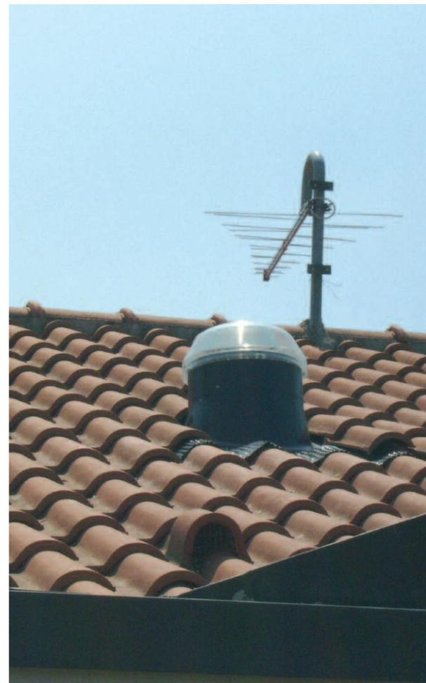
Il dispositivo Solatube nell'edificio di Vicenza: a sinistra il sistema illumina il vano scala, al centro migliora la luminosità del bagno. Nella foto a destra il dispositivo sul tetto.
