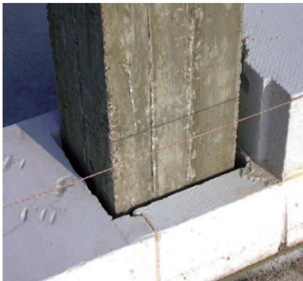
Particolare dell'inserimento del pilastro in c.a. nella muratura "porenbeton".
