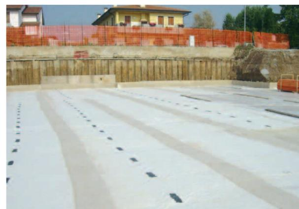
Il telo bentonitico nell'impermeabilizzazione della platea.
