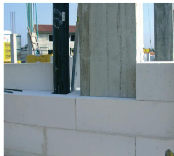
Muratura realizzata con il blocco in calcestruzzo cellulare "porenbeton" di YTONG.
