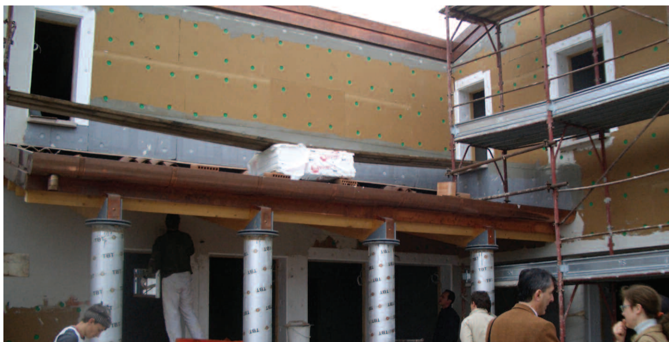
Fig. 2 - Panoramica di cantiere.
