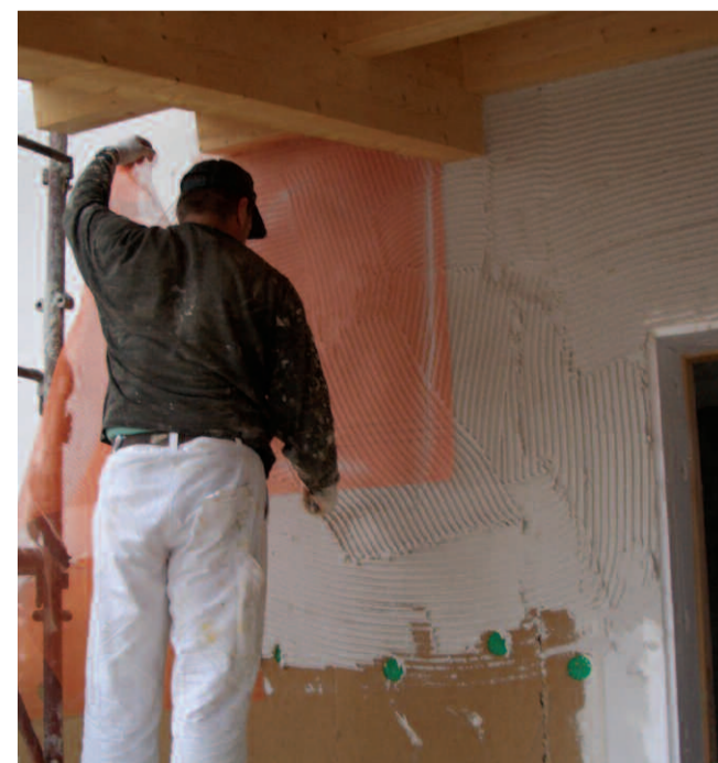
Fig. 3 - Applicazione della rete d'armatura.
