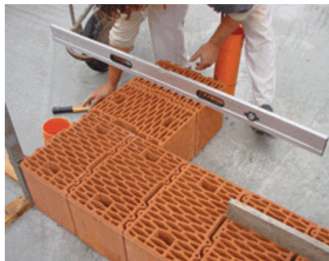
Posa in opera della muratura in blocchi rettificati.
