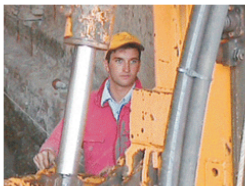
Operatore durante una delle fasi di cantiere
