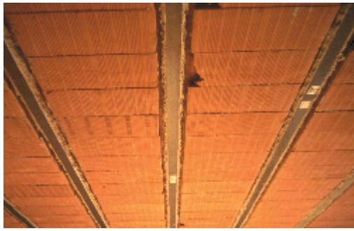
**Fig. 6 - Intervento MAPEI Carboplate ultimato**
