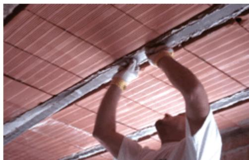
**Fig. 4 - Posa del CARBOPLATE E170/50 Mapei**
