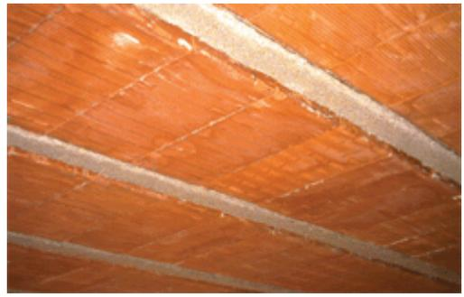
**Fig. 7 - Solaio pronto per l'intonacatura**
